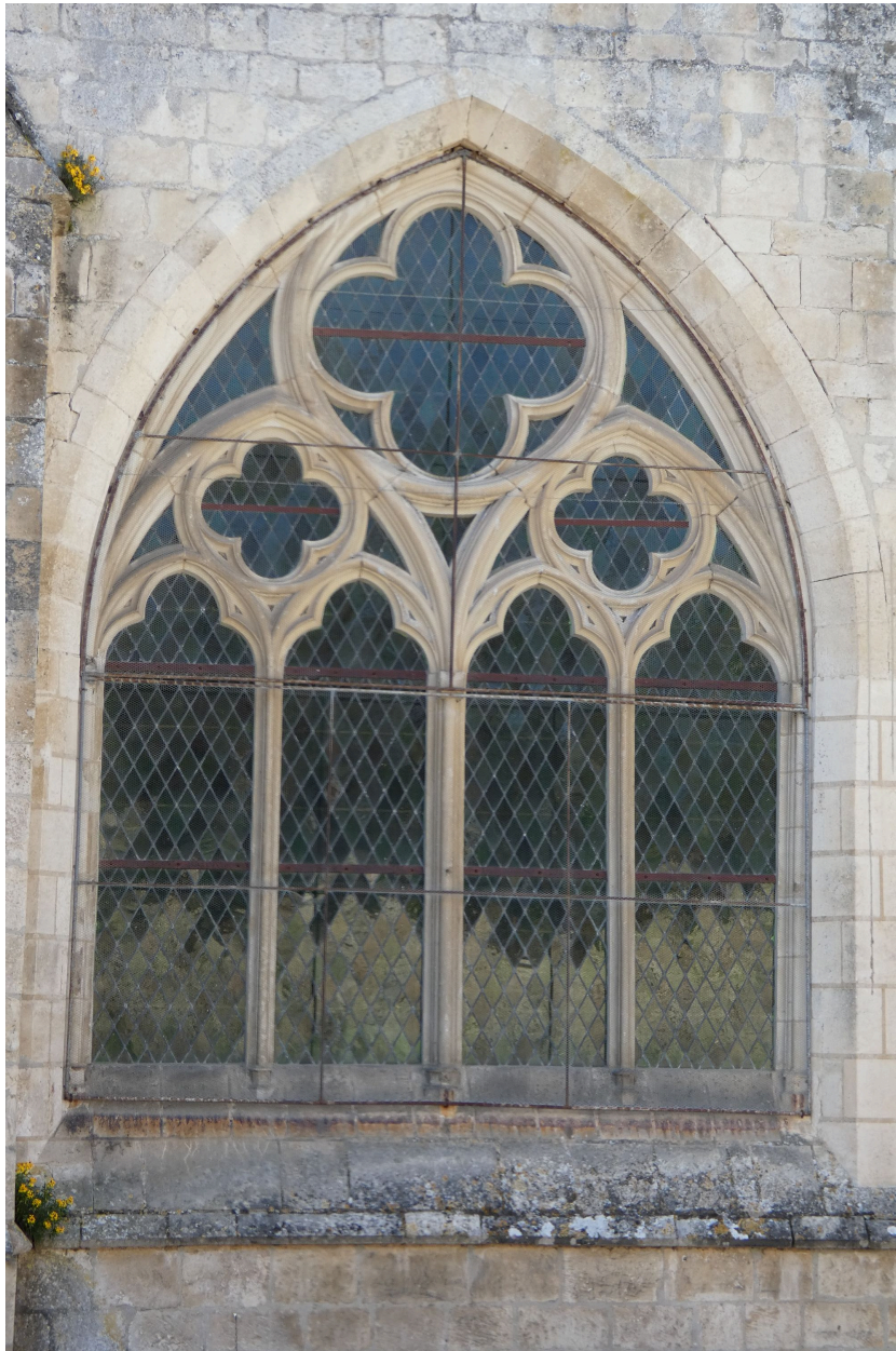
La baie de la chapelle latérale nord vue depuis l'est.
