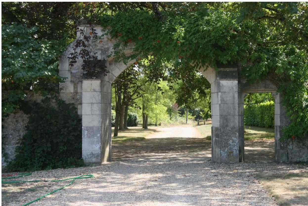
Portail d'entrée et porte piétonne, revers.
