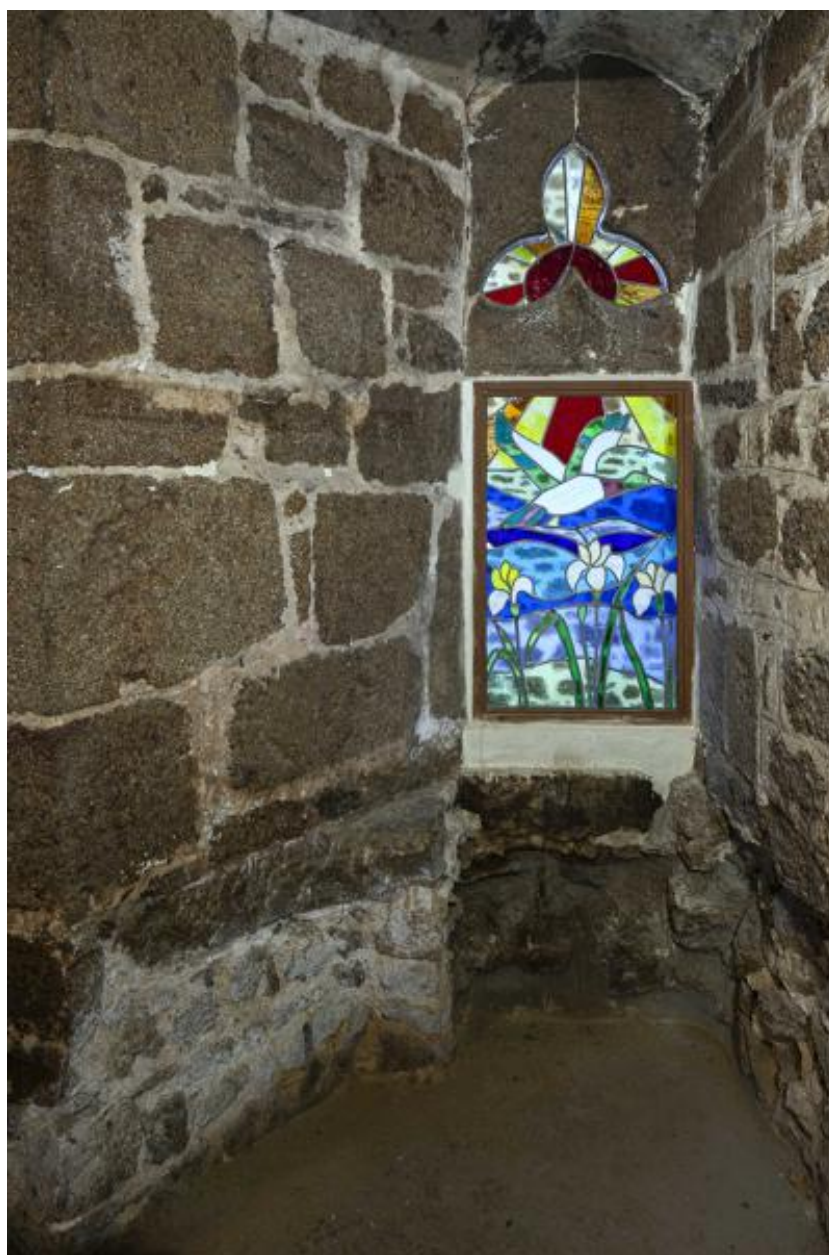
Ebrasement intérieur de la baie trilobée.
