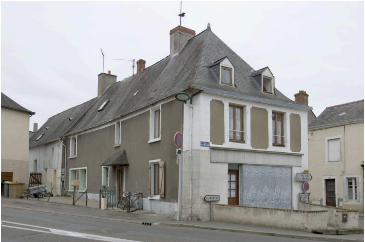
Vue depuis la route du Mans au nord-est.
