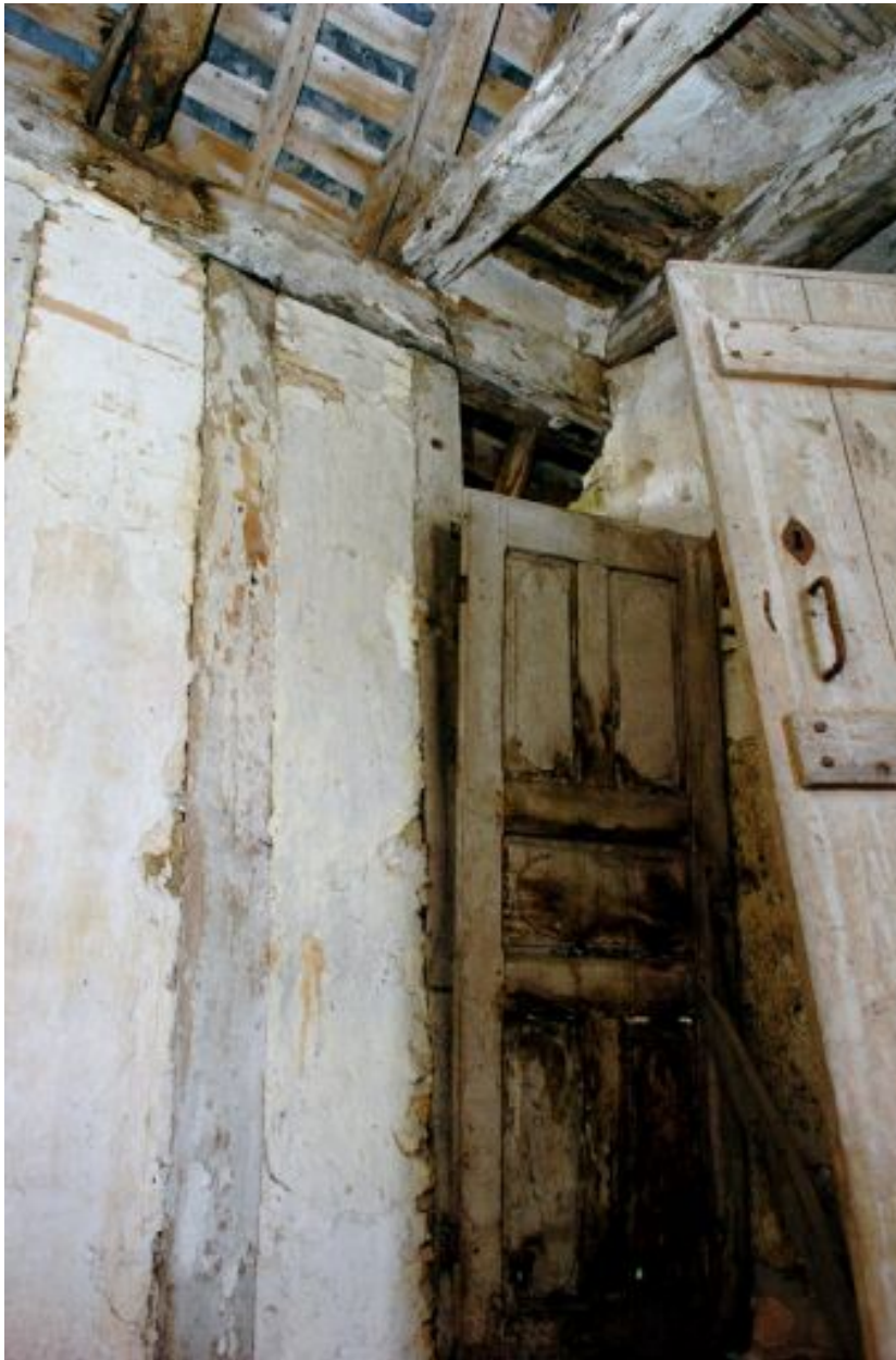
Mur en pan-de-bois de la façade postérieure de l'aile en retour.
