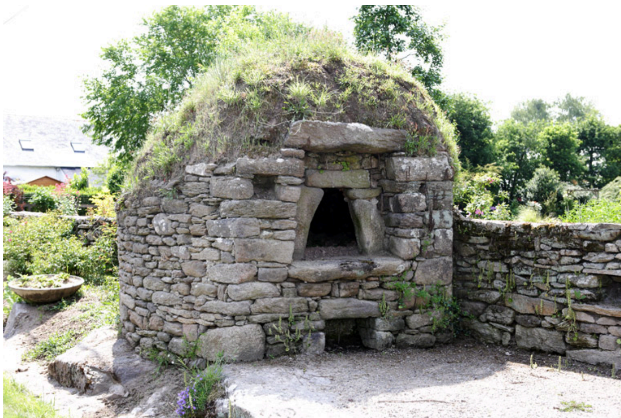
Kergaigne. Four à pain avec niche au sol pour recueillir les braises.
