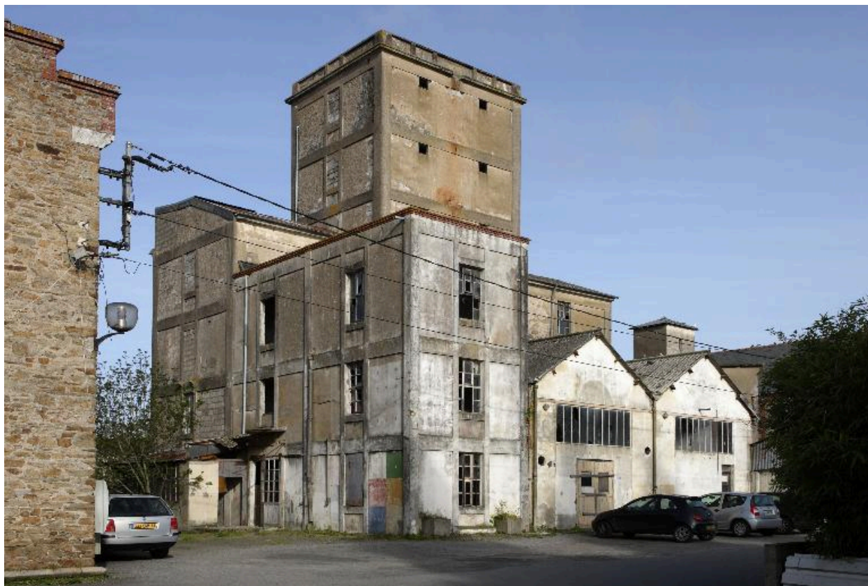
Arrière du bâtiment Hennebique, 1898.
