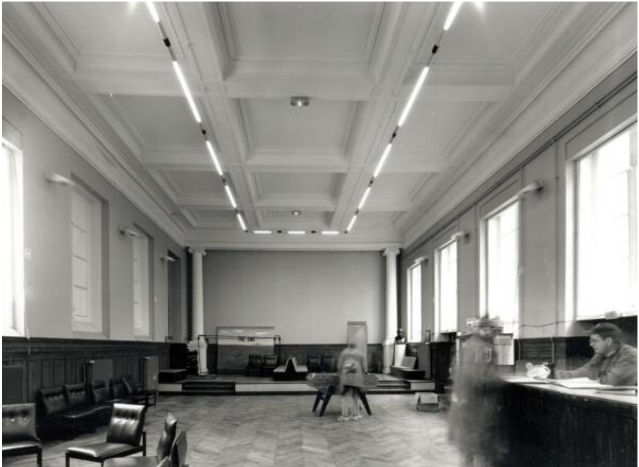
Salle de distribution des prix (par Isabelle, Ch.-E.) : vue en axe longitudinal ouest-est.
