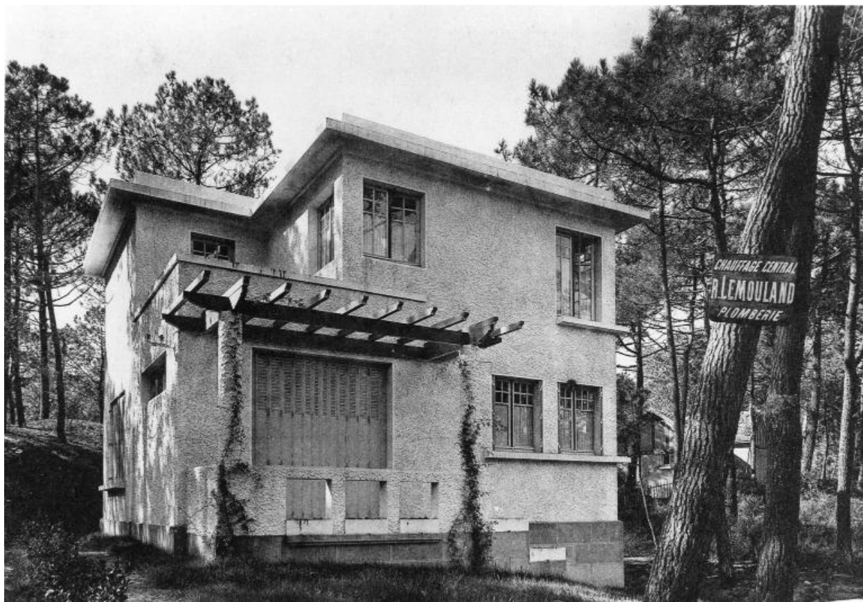
Façade nord de la villa L'Ourida.
