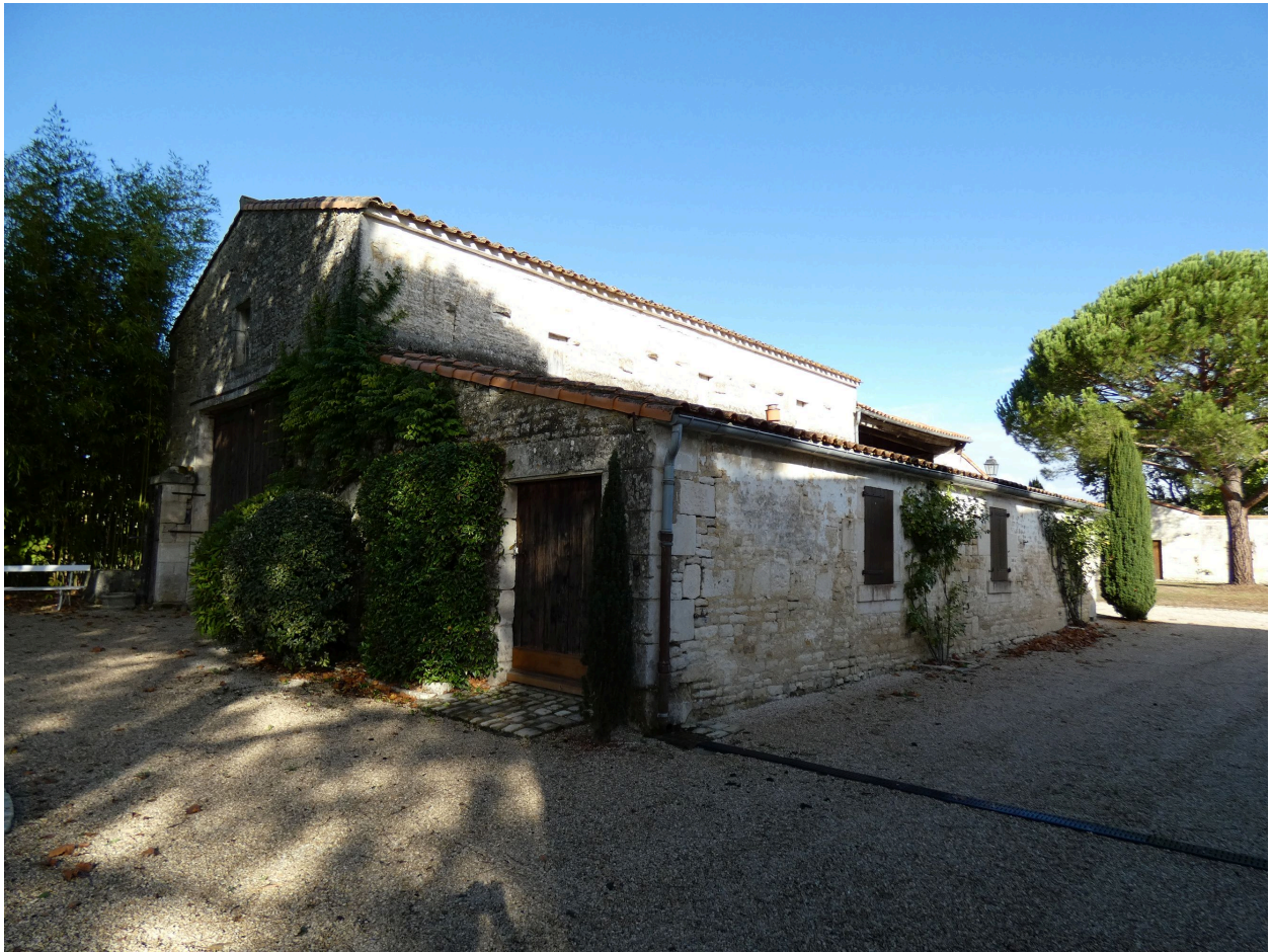
Les communs et dépendances, à l'ouest de l'ensemble, vus depuis le sud.
