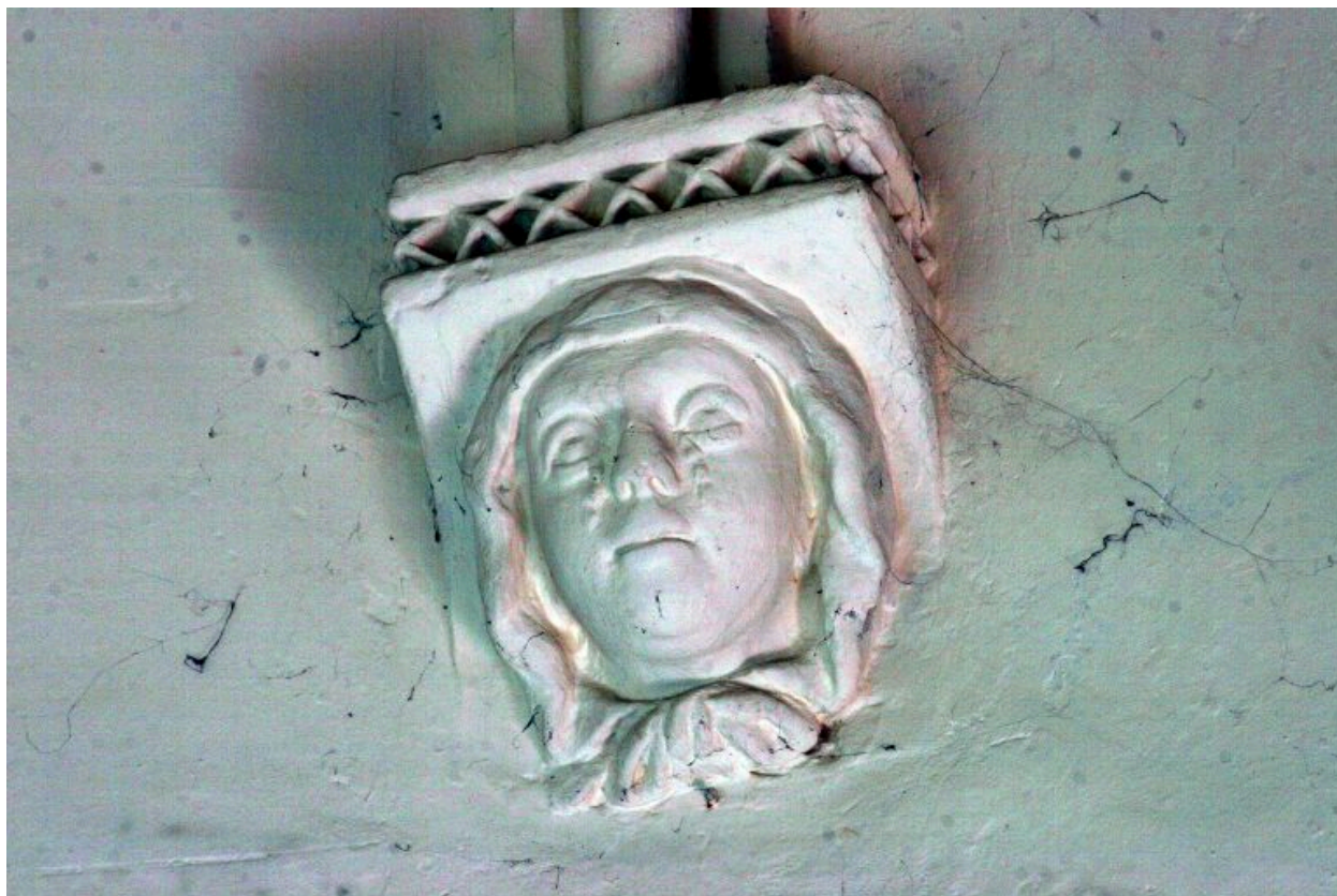
Voûte du chœur : culot 9.
