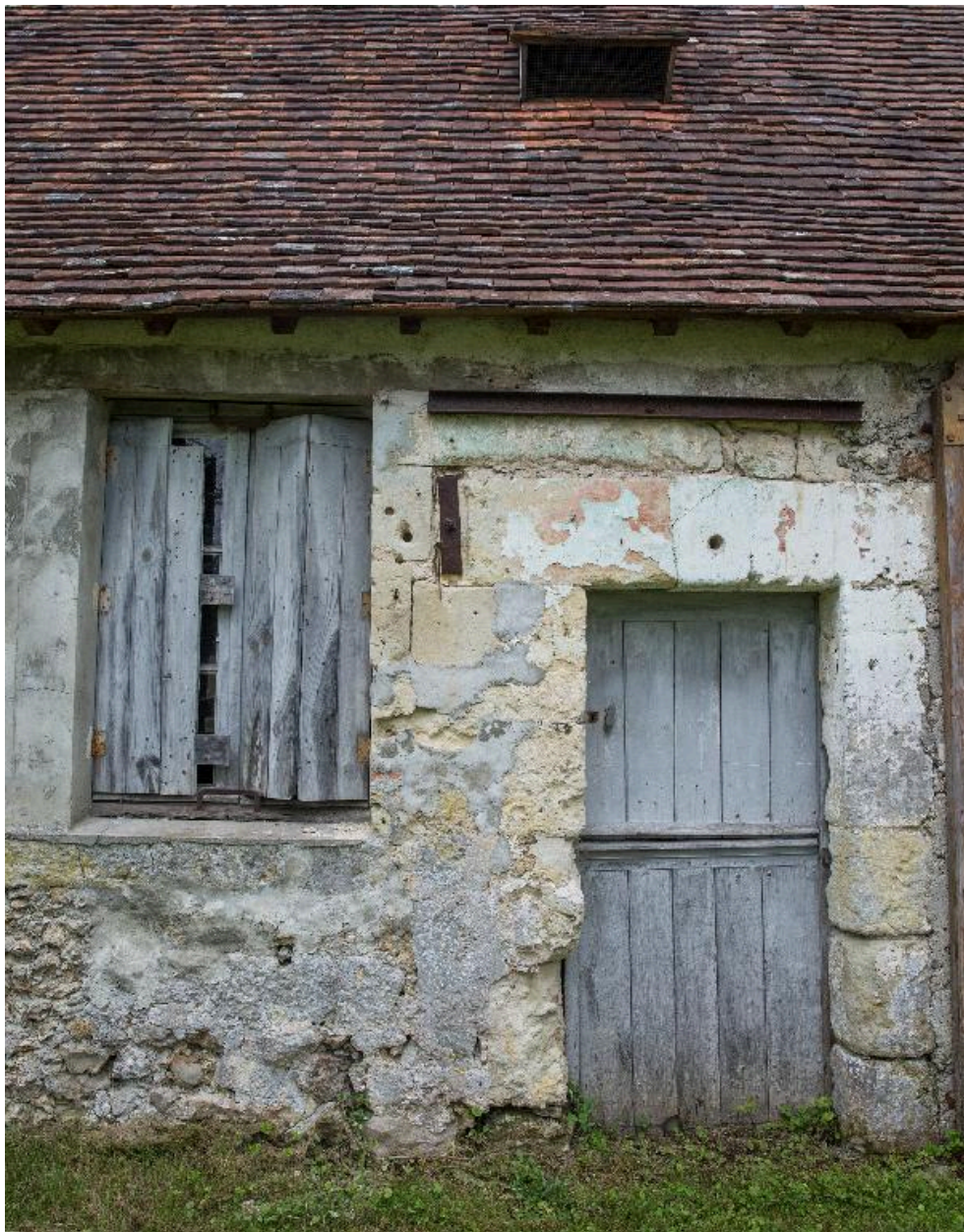
Façade sud, détail : fenêtre et porte.
