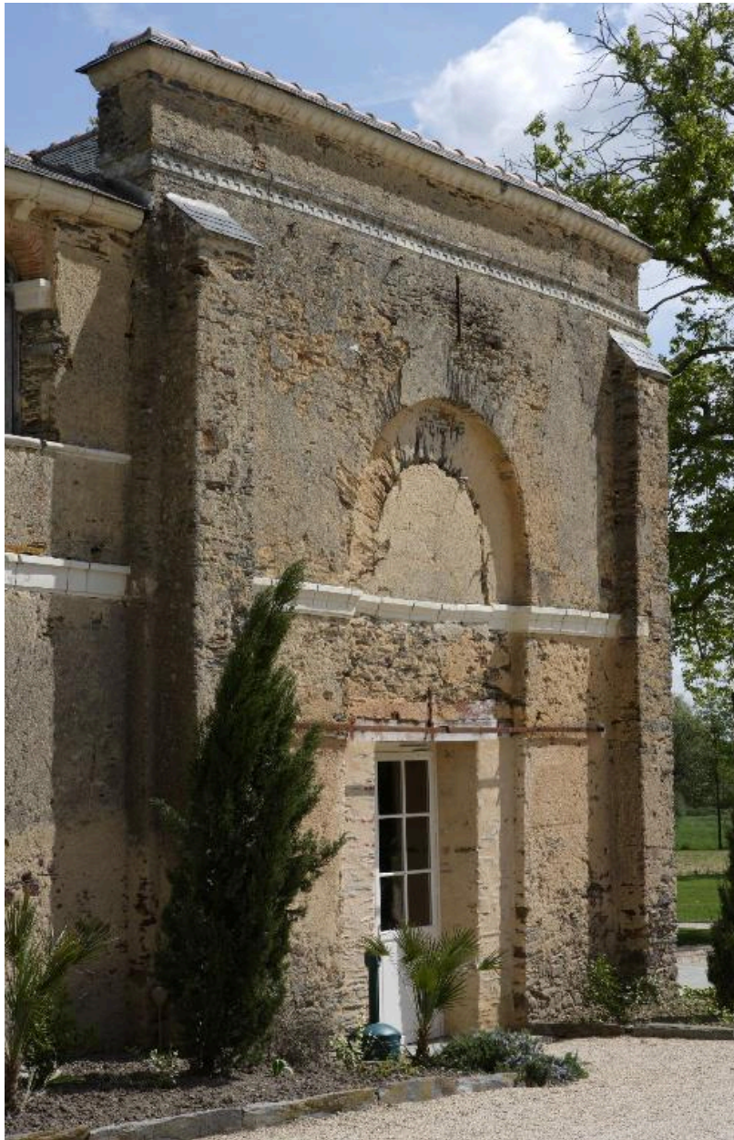
Bâtiment est, détail façade ouest.
