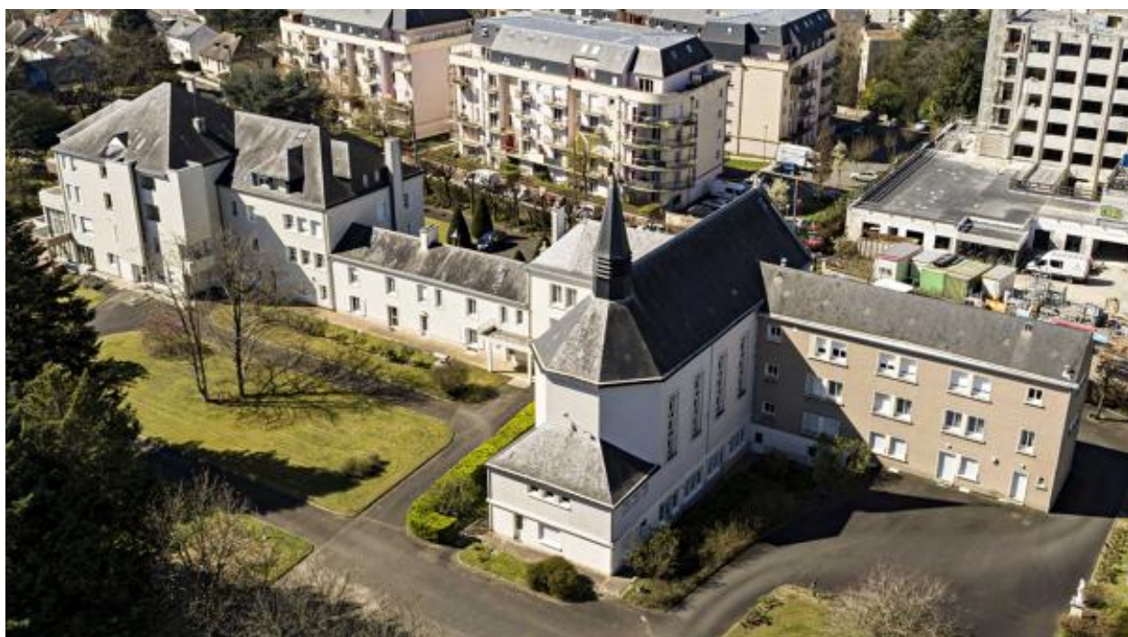
Vue aérienne du monastère depuis le nord-est.
