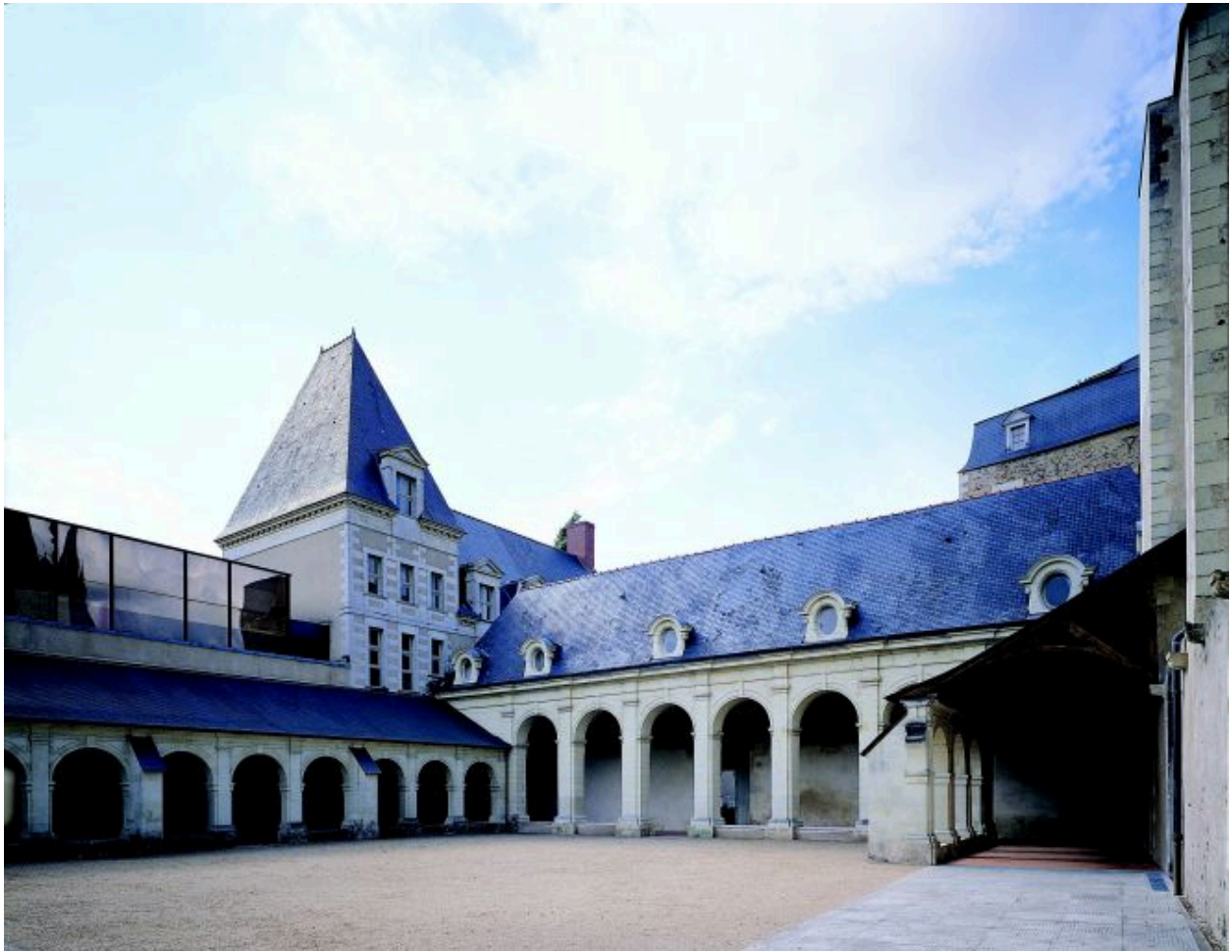
Vue d'ensemble des galeries subsistantes du cloître, depuis l'angle nord-est de la cour.
