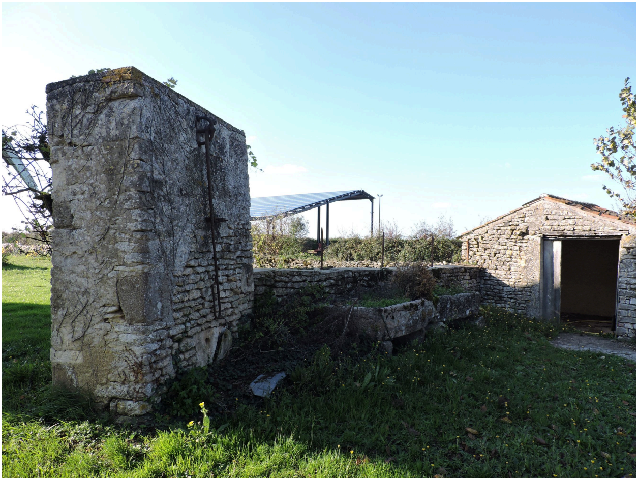
Puits, abreuvoirs et toit au nord du moulin, vus depuis l'est.
