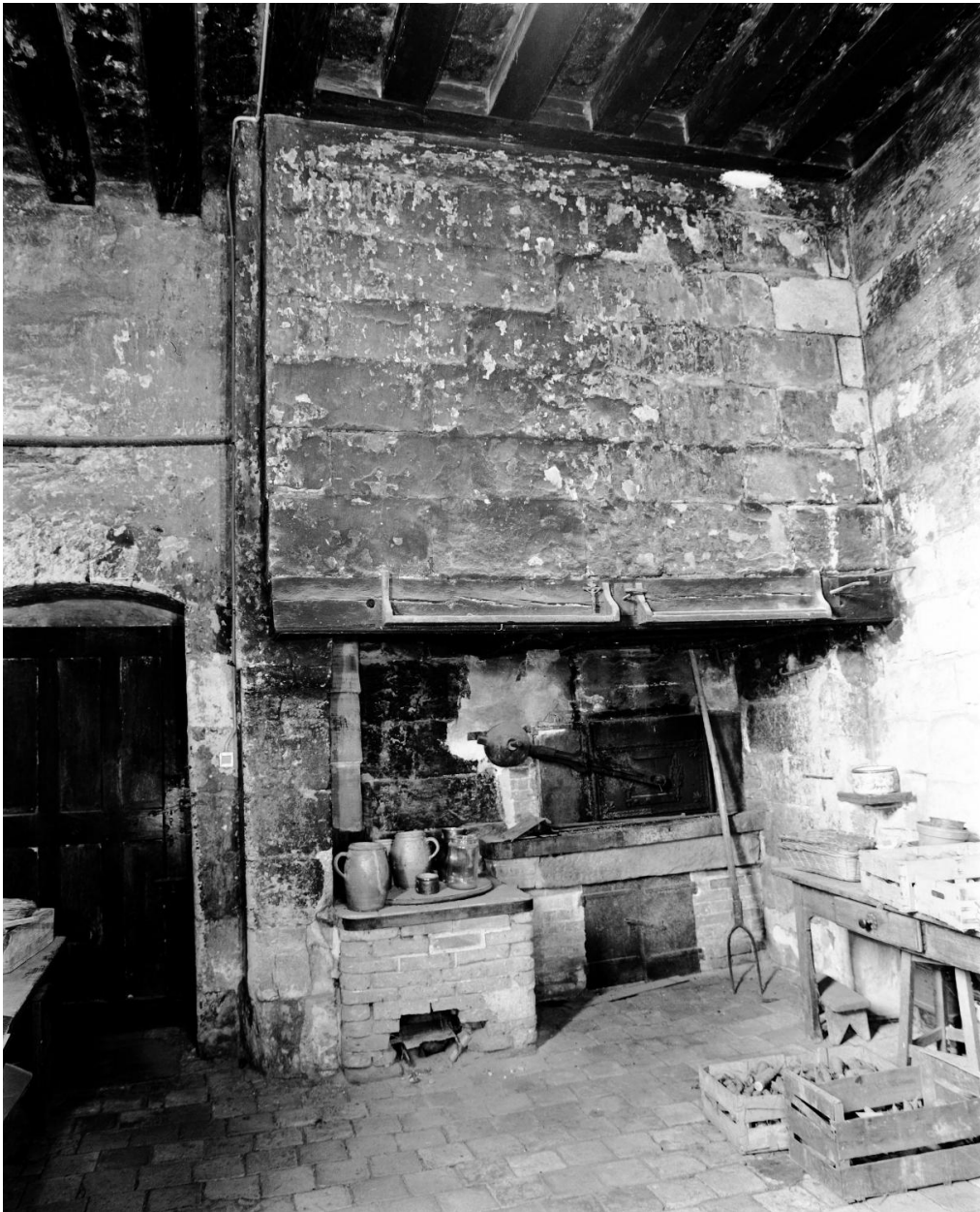
Bâtiment dit des lieux communs de communs, rez-de-chaussée, deuxième boulangerie (sur le plan de 1796), mur est : cheminée, vue d'ensemble.
