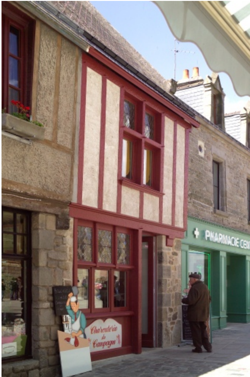
Détail de la moitié occidentale de la façade nord, après travaux.
