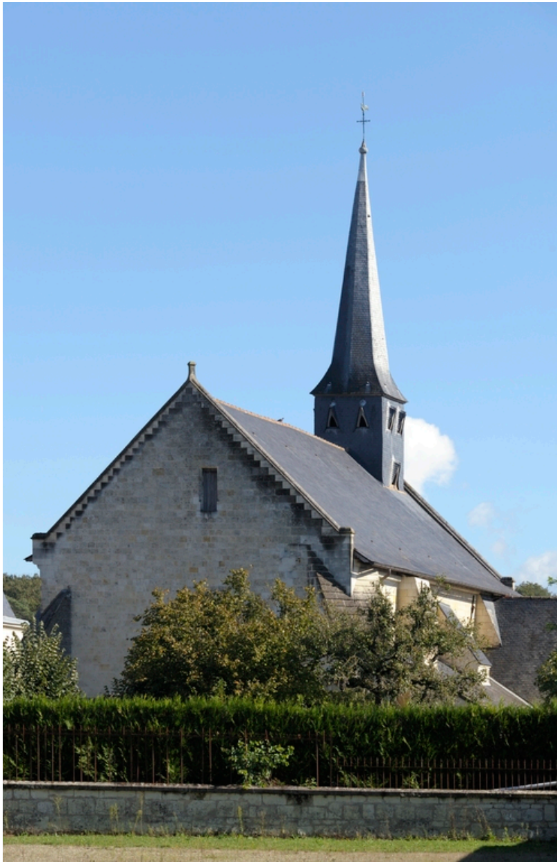
Vue d'ensemble depuis le sud-ouest de l'église.
