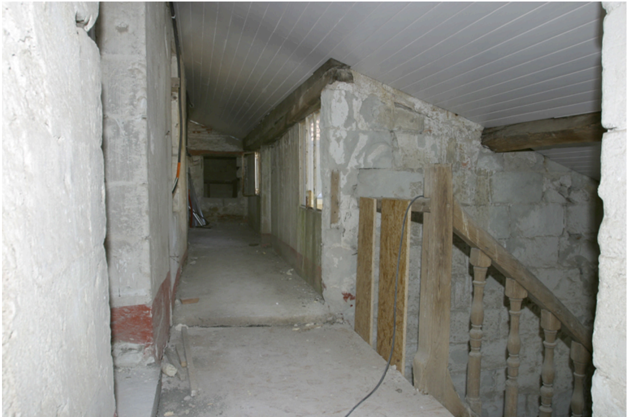
L'étage de comble : la coursière longeant la façade sur la cour.
