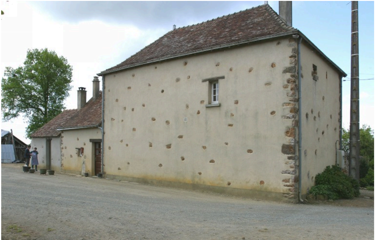
La maison de maître : façade arrière vue depuis la cour au nord-est.
