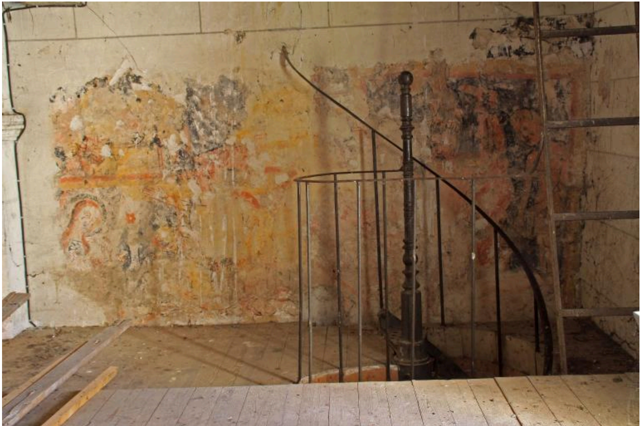
Nef, mur sud, tribune : arrivée escalier Bollée.
