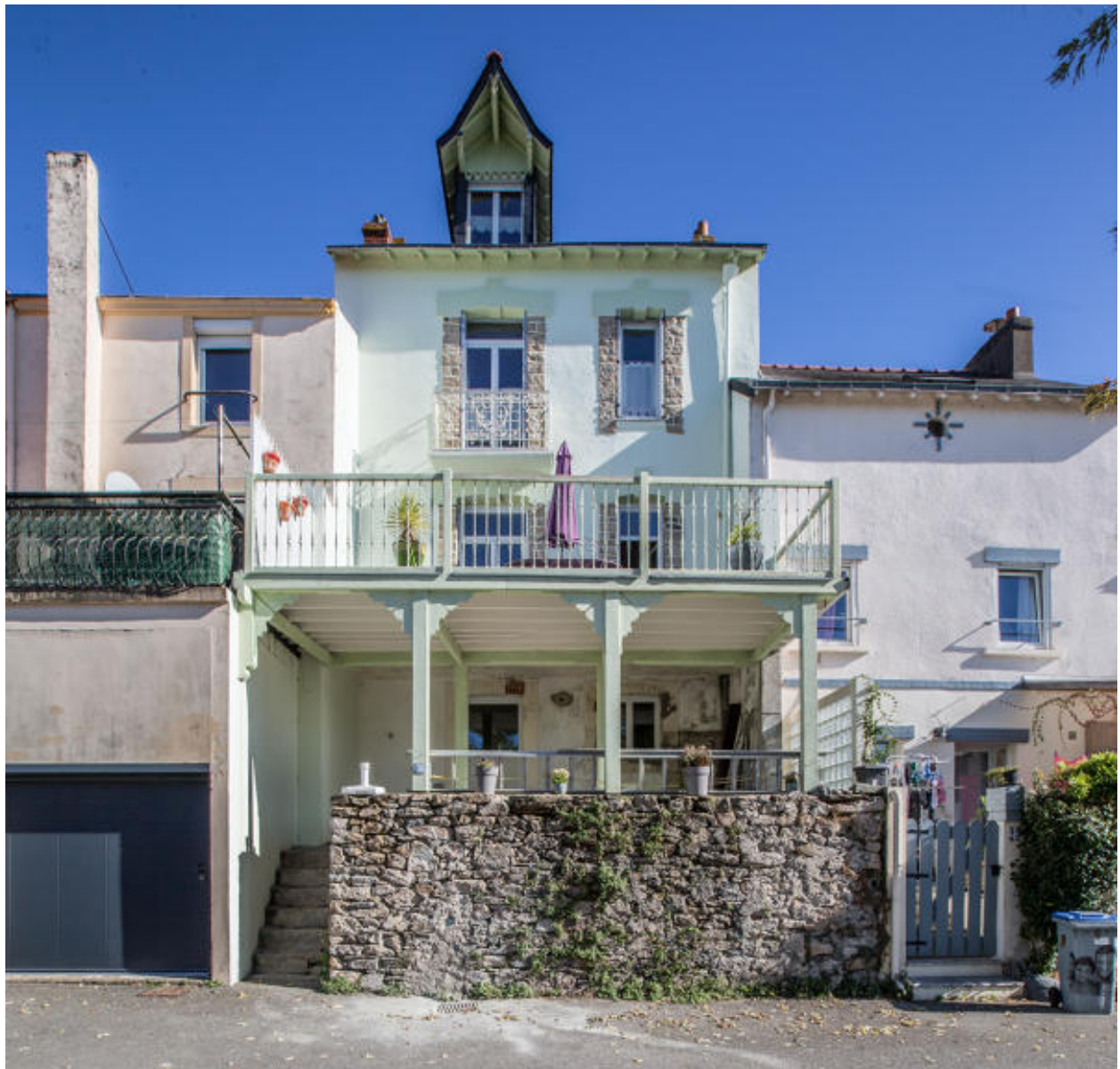
Maison, 29 rue Joseph-Tahet. Façade postérieure côté Loire.
