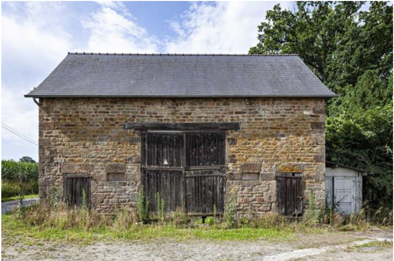
Grange-étable au sud du hameau.
