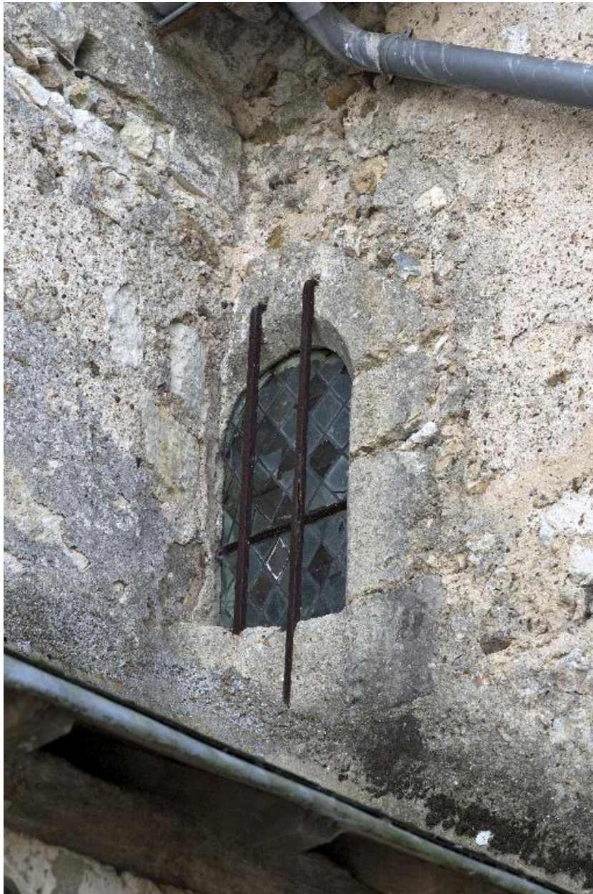
Nef, façade nord : baie (escamotée avec la construction de la chapelle nord au XVIIe s.).
