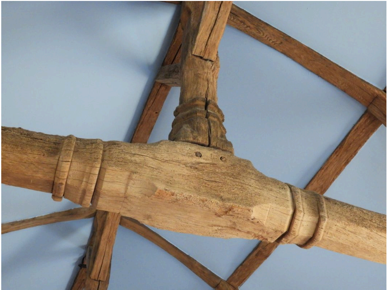
Détail d'une ferme : entrait et poinçon à décor mouluré.
