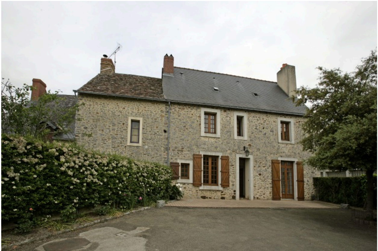
La façade postérieure vue depuis la cour au sud-ouest.
