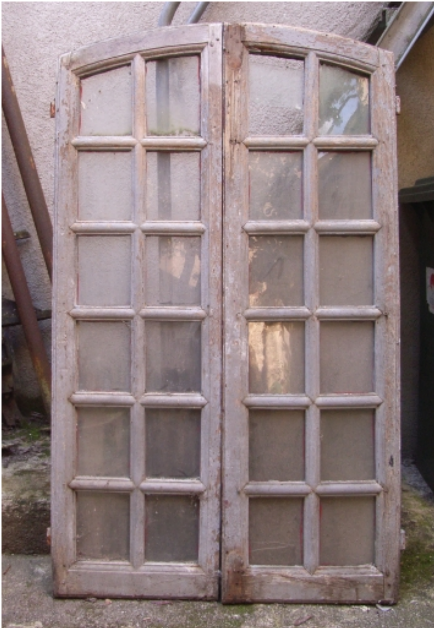
Ancienne huisserie de fenêtre déposée.
