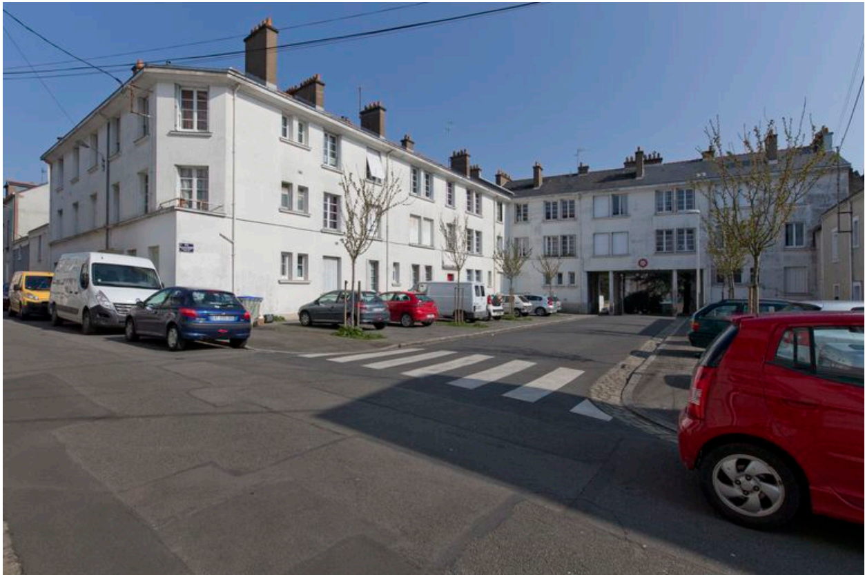
Immeuble rue du Docteur Grimaud.
