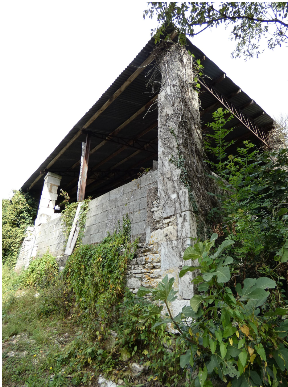
Le hangar vu depuis le sud-est.
