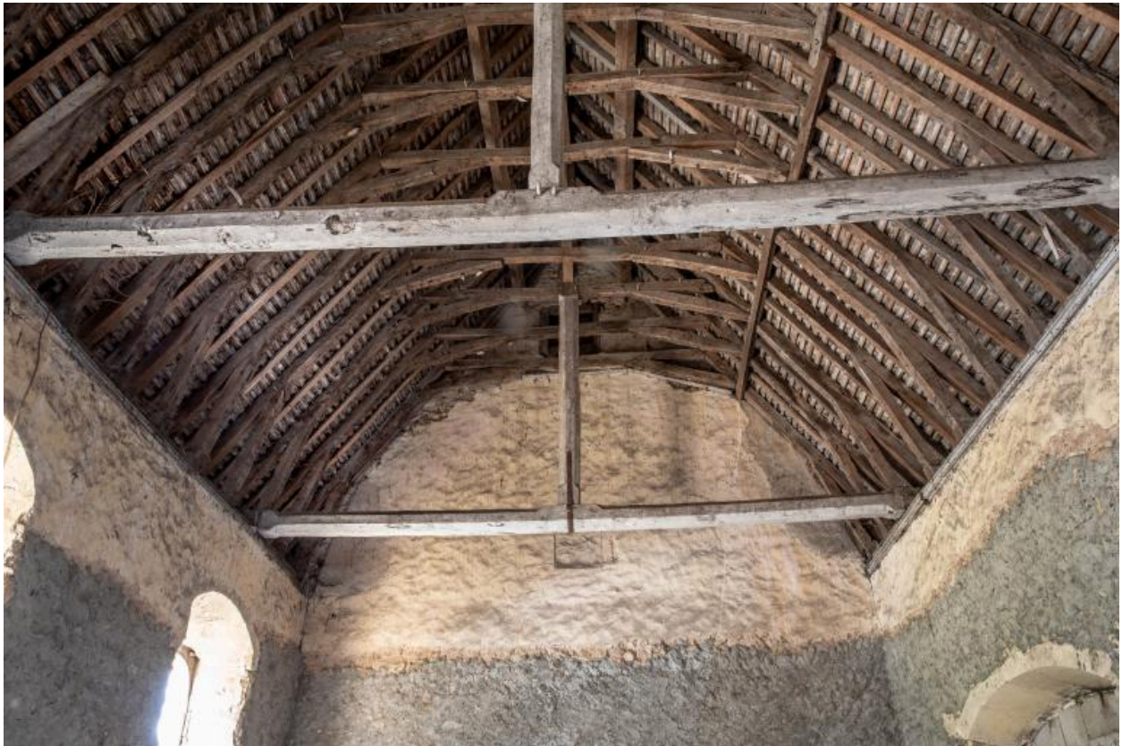
La charpente de la chapelle.
