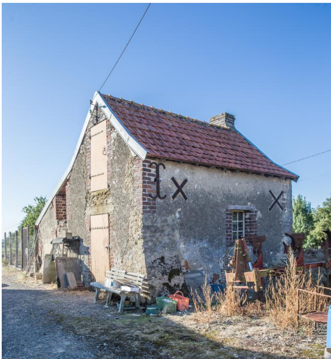
Ferme 2, buanderie à l'arrière des soues.
