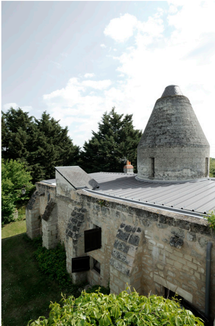
Moulin Neuf : façade nord.
