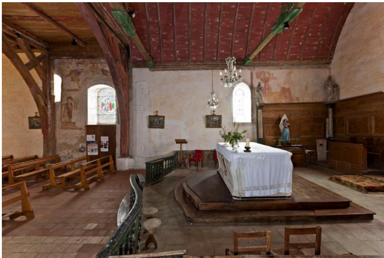
Chœur et entrée nord, vus depuis le sud.
