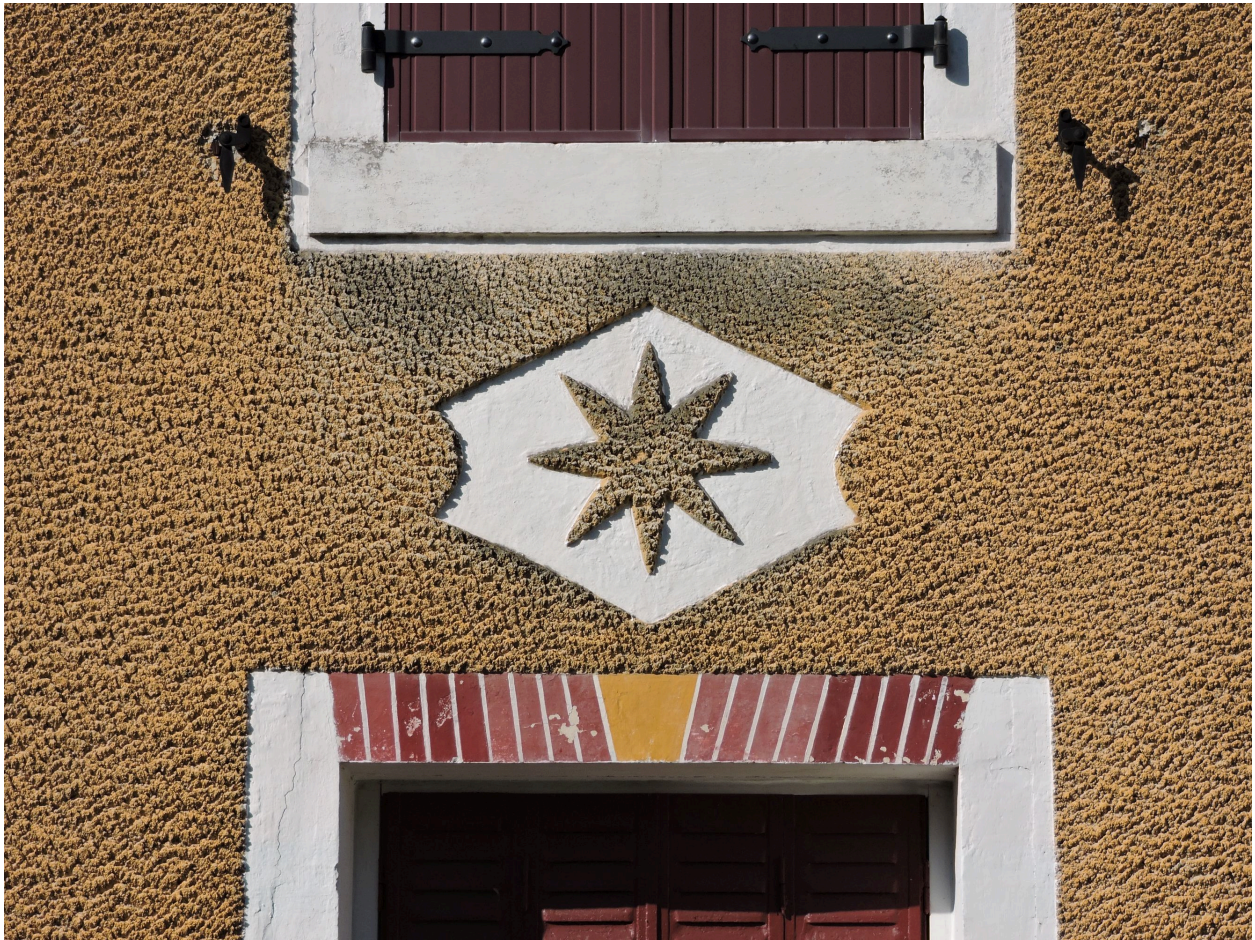
Détail du décor de la façade : crépi ocre, cartouche avec étoile, linteau en brique.
