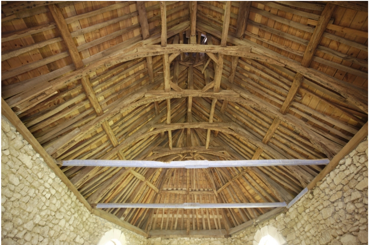
Chapelle. Vue de la charpente depuis l'ouest.
