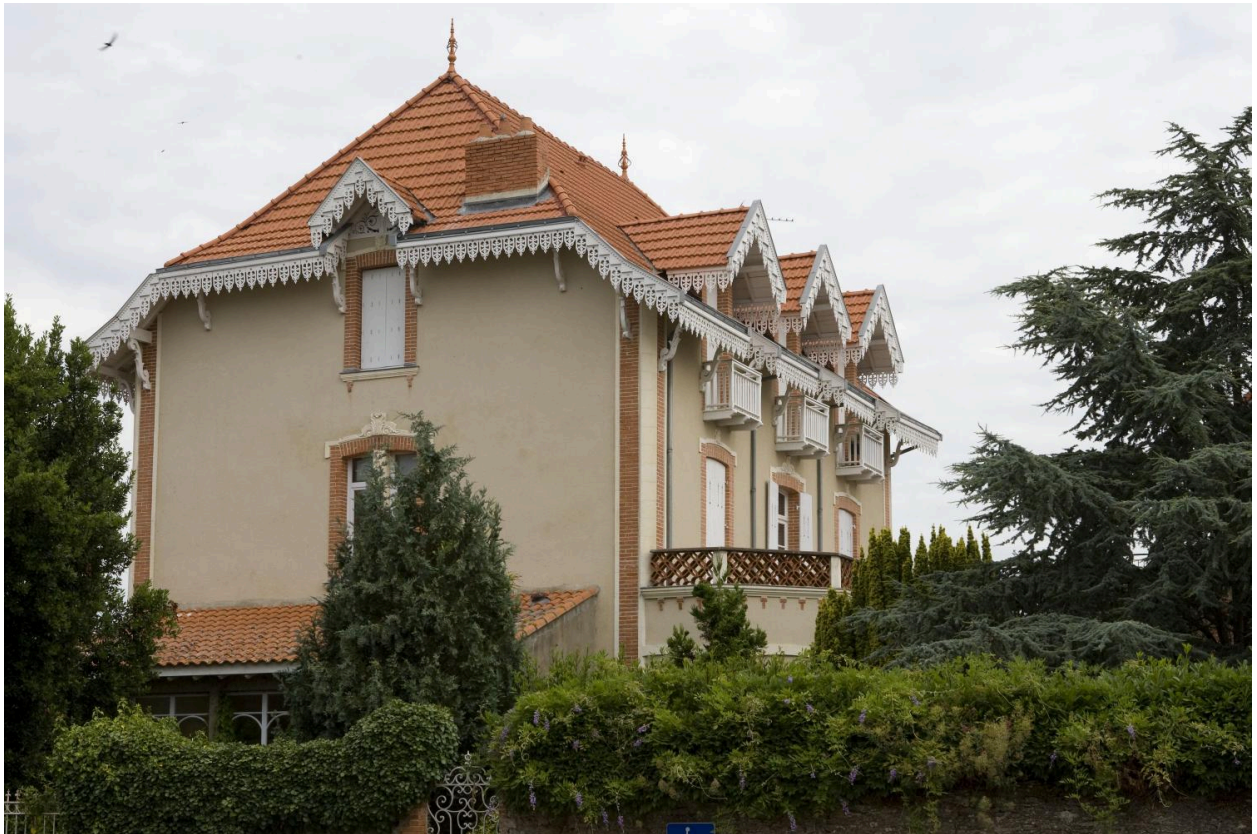
Villa dite Chalet Gautier, élévations antérieure et latérale, prises du sud.
