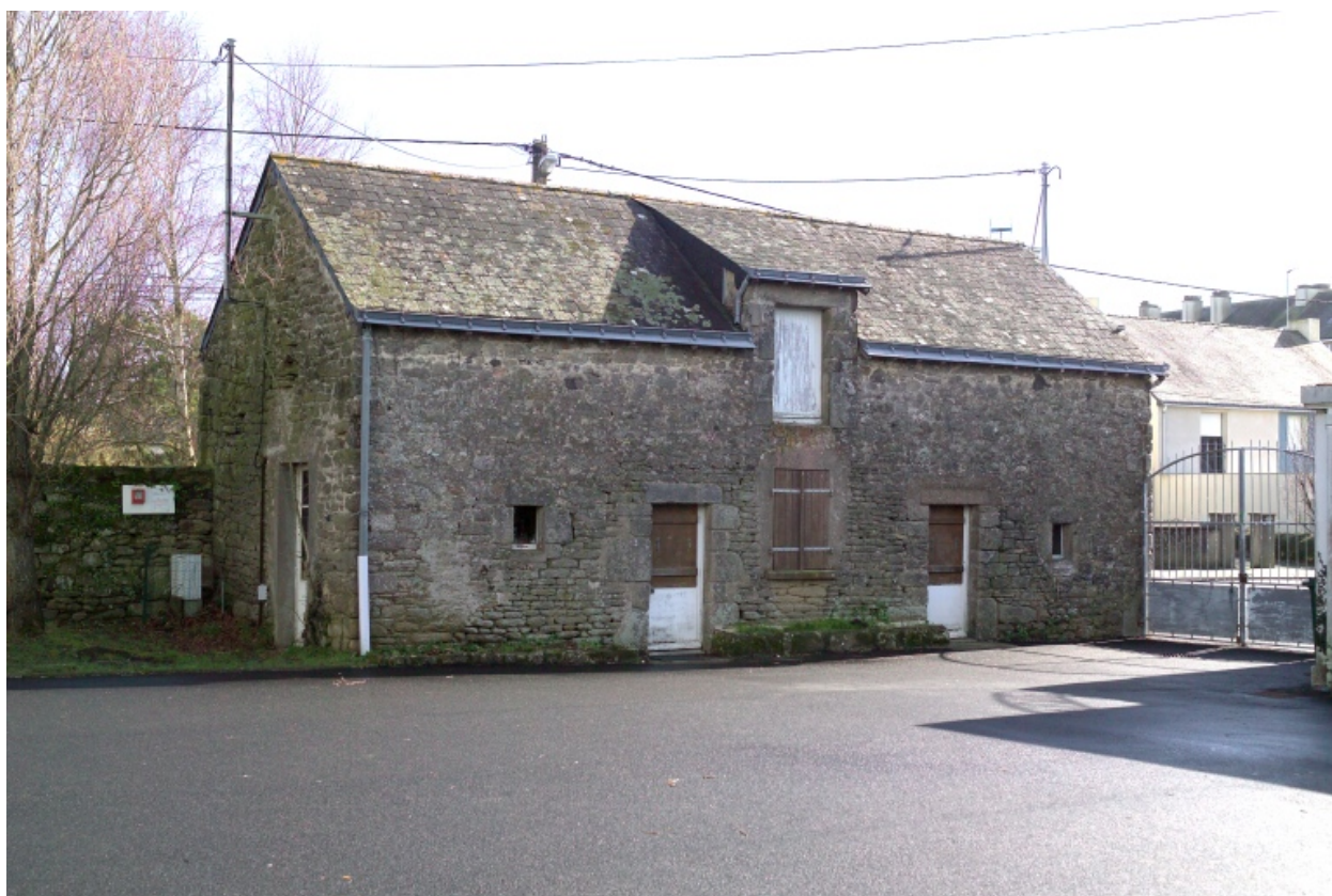
Bâtiment est. Vue de la façade ouest.
