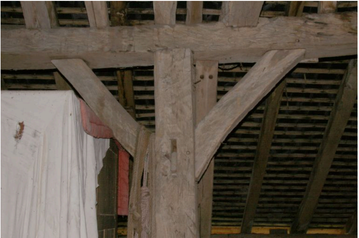
Grange sur poteau, détail.
