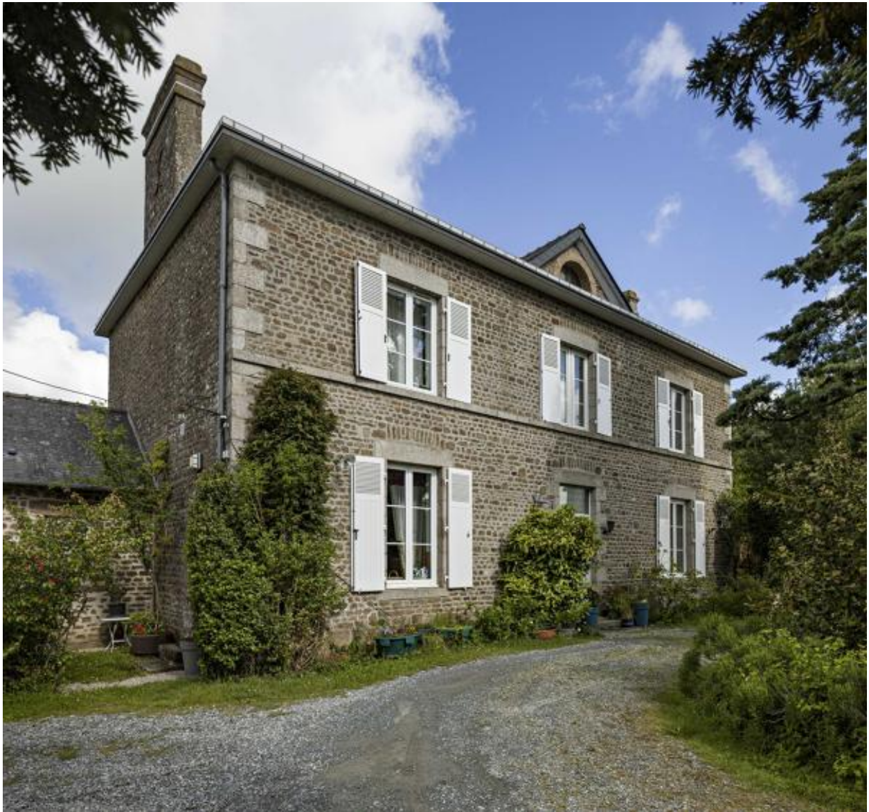
Presbytère de Niort-la-Fontaine, corps de logis édifié en 1852 par François Godin.
