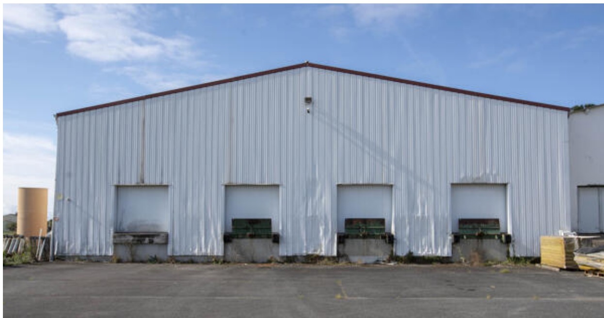
Le dernier magasin construit et ses quais.
