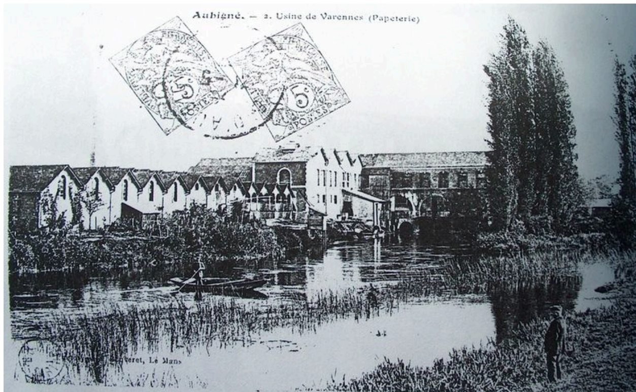
Vue d'ensemble de la papeterie.
