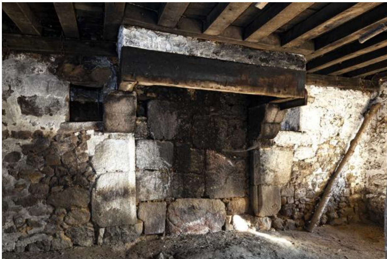
Logis nord, cheminée.
