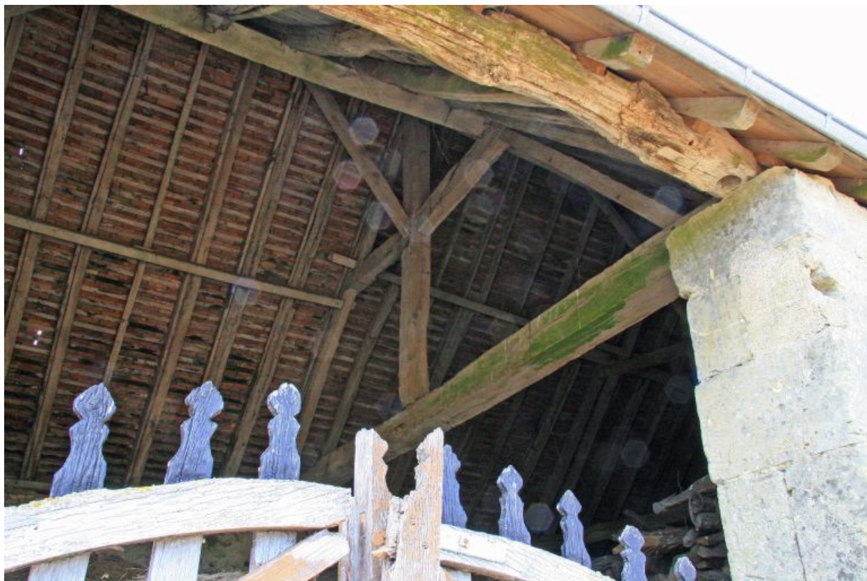
La grange : charpente à pannes.
