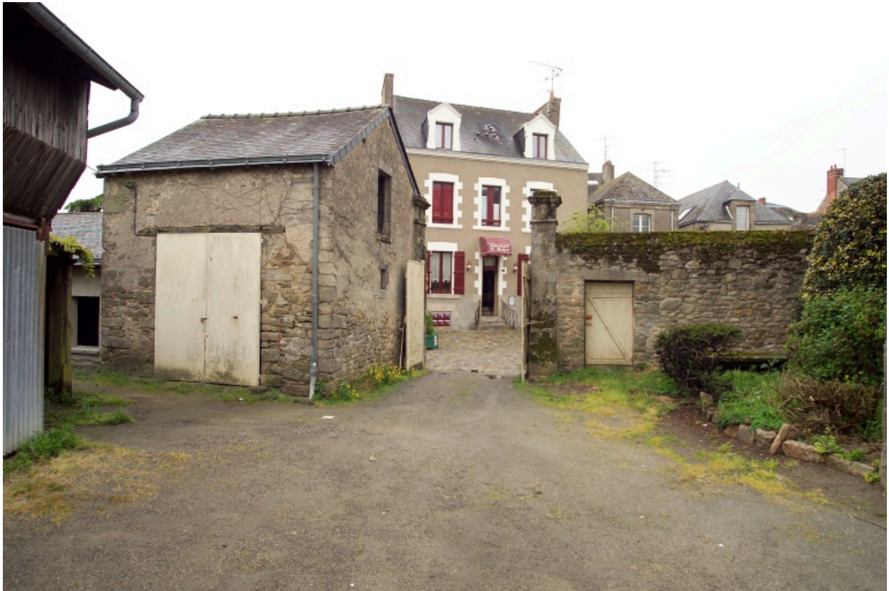
Vue du mur de clôture avec portail et de la petite dépendance bordant la rue du Vieux Marché.
