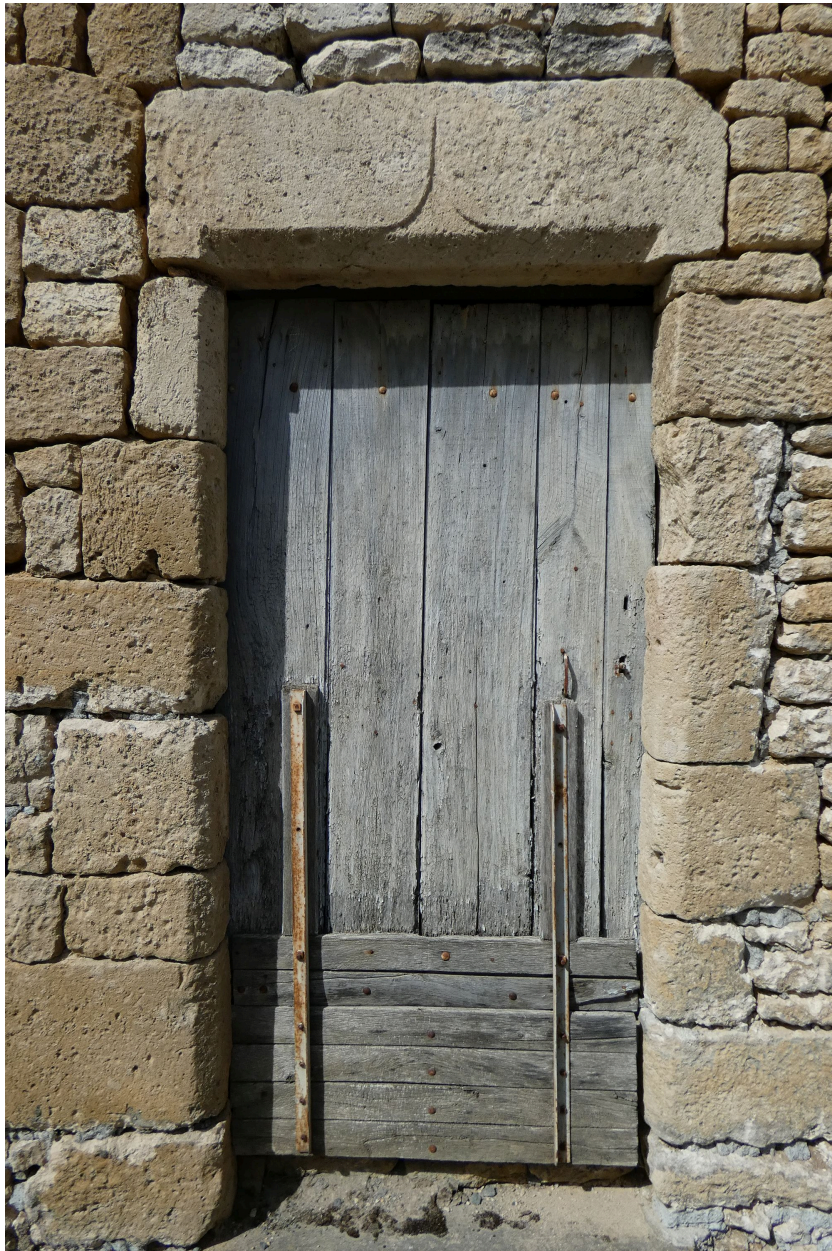
La porte de la remise, avec son linteau orné d'une accolade.
