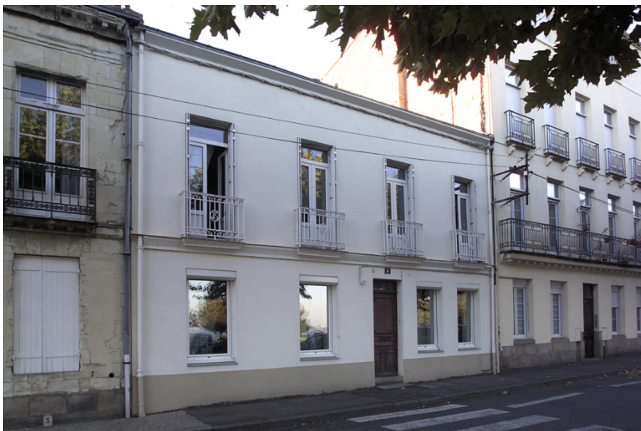
La façade antérieure de la maison n° 4 quai Gautreau.
