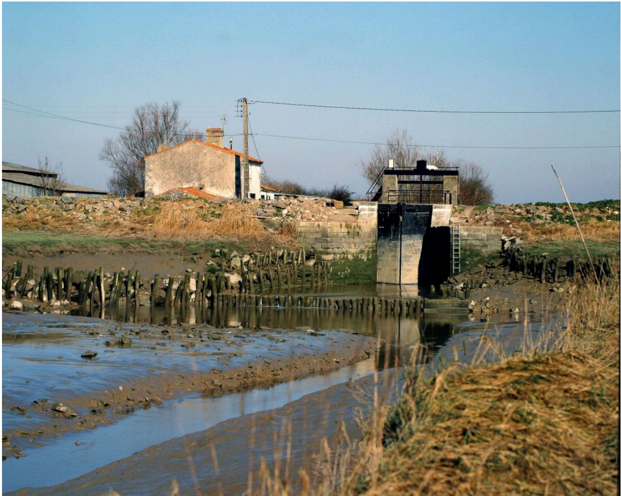
La porte et la maison de garde vues depuis le sud en 2000.
