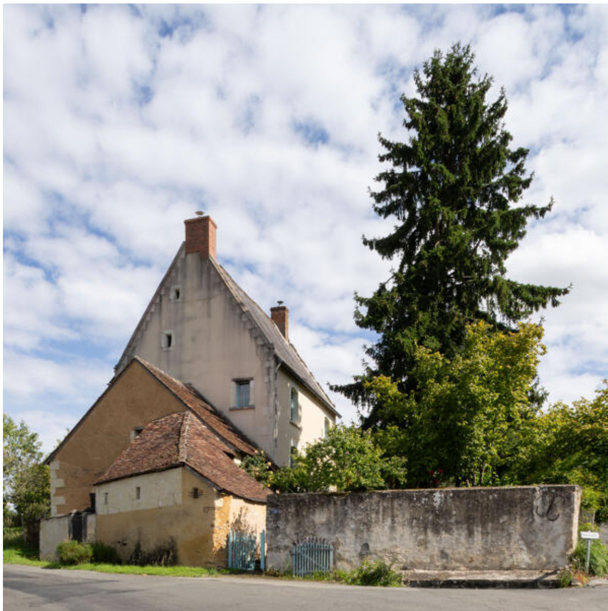
Vue d'ensemble, depuis l'ouest, rue de la Petite Fontaine.
