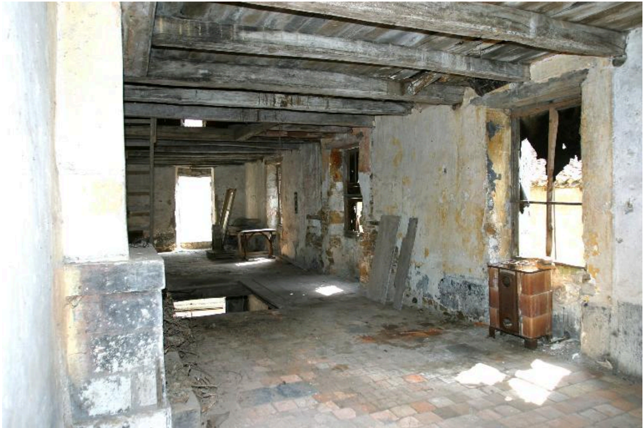
Vue d'ensemble du premier étage vers la rue.
